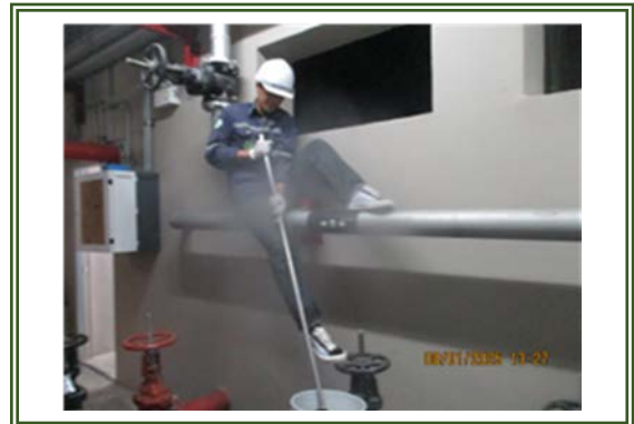
รูปที่ 3-13 การเก็บตัวอย่างคุณภาพน้ำ บริเวณถังเก็บน้ำชั้นดาดฟ้า
